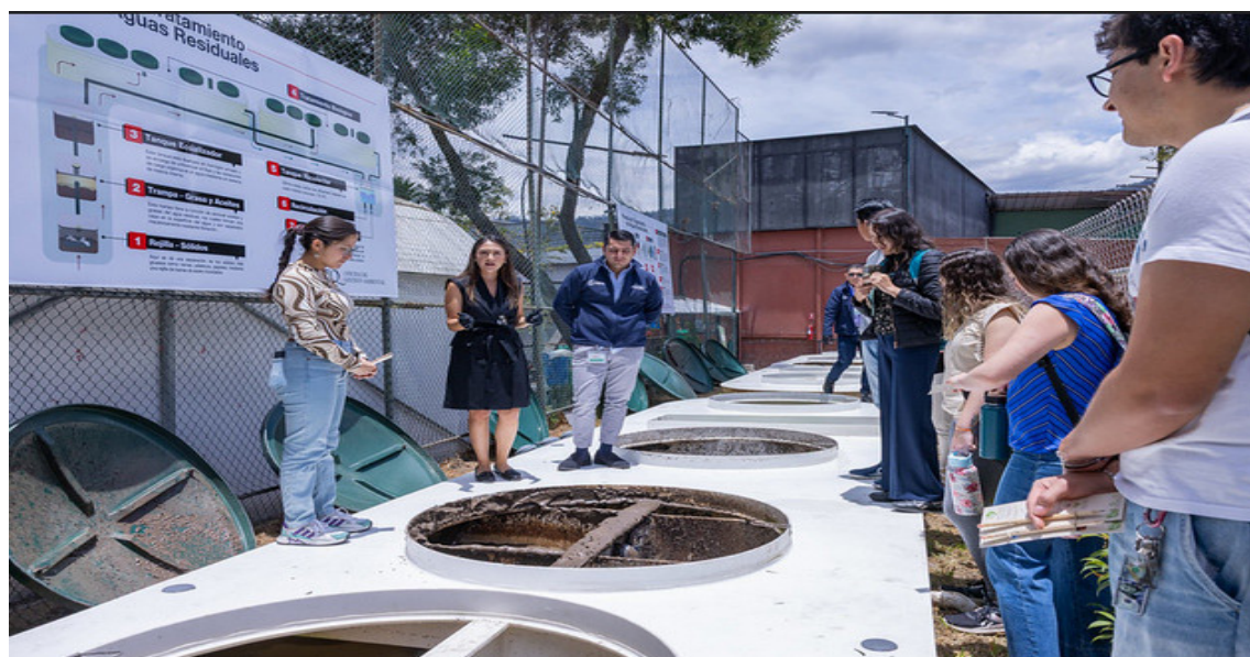
Planta de Tratamiento de Aguas Residuales (PTAR-USFQ)
