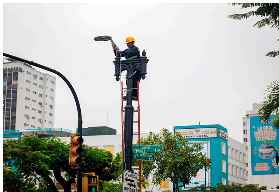
Los trabajos comenzaron esta semana y se extenderán a lo largo de los dos kilómetros de la avenida, incluyendo algunos puntos en plazoletas cercanas. Además, se reemplazarán 40 postes metálicos en mal estado. Cada intervención se realizará por fases, con relleno compacto y bases reforzadas, para reducir molestias y garantizar una infraestructura duradera. Durante todo el proceso se mantendrá señalización preventiva para facilitar la movilidad.
